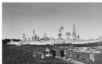
В. Южная и восточная стены. Вид с юго-востока. Фото начала XX в.
